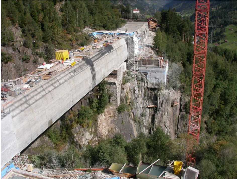
Abbildung 4: Rorbachbrücke während der Instandsetzung 2007
