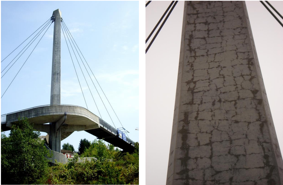
Abbildung 3: Charakteristisches AAR-Rissbild am Pylon einer Schrägseilbrücke
